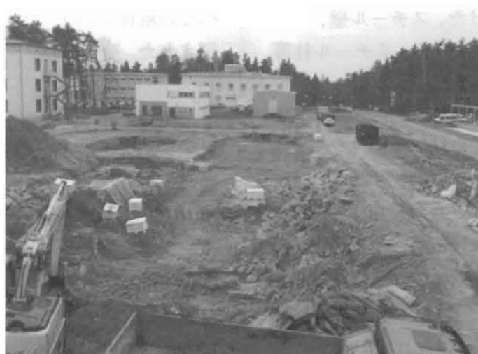
図2 建家8dの解体作業現場
